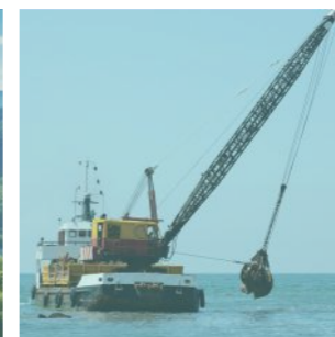
Dragado y Retirada de Sedimentos
