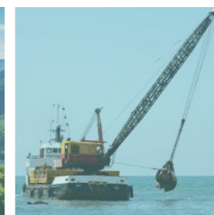
Dragado y Retirada de Sedimentos
